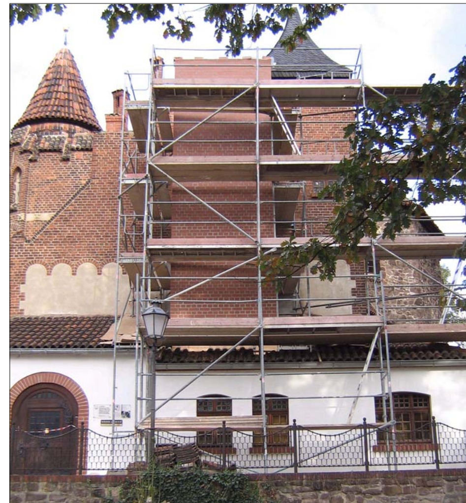
Bauarbeiten zum Ausbau eines behindertengerechten Aufzuges.
