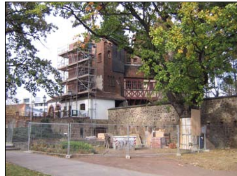
Der neue Fahrstuhlschacht ist hochgemauert.
