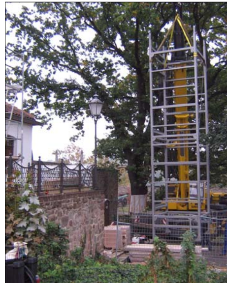
Einsetzen des Fahrstuhlgerüsts.
