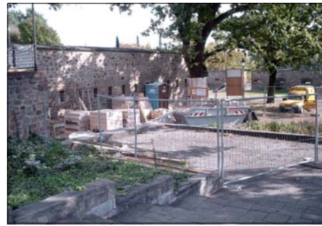
Einrichtung der Baustelle.
